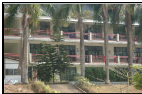
相片 2-4 南投縣國姓鄉北山國中 說明 RC 造斜屋頂
