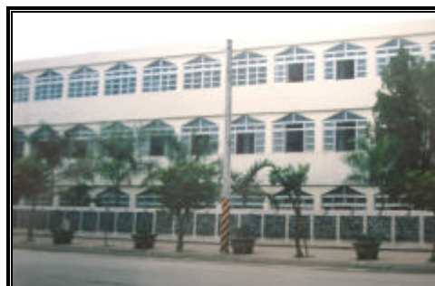
相片 2-14.3 南投縣埔里鎮南光國小 說明 F 棟校舍 921 地震前原貌 - 增建 3F 後之背立面
