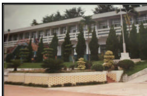
相片 2-12.1 南投縣埔里鎮南光國小 說明 D 棟校舍 921 地震前原貌
