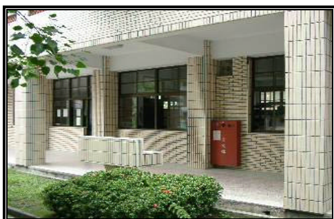
相片 2-7.2 南投縣竹山鎮延和國中 說明 因為有設置翼牆，故於 921 地震後損害輕微
