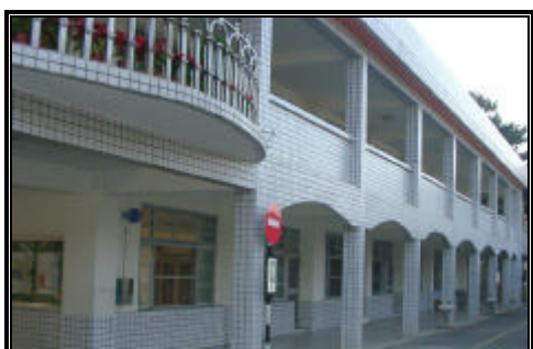
相片 2-19.1 南投縣埔里鎮愛蘭國小 說明 北棟校舍地震後現況，雙邊 走廊，單側有廊柱系統
