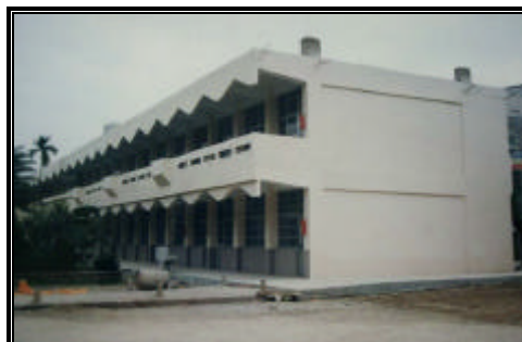
相片 2-14.1 南投縣埔里鎮南光國小 說明 F 棟校舍 921 地震前原貌 - 未增建 3F 前之正立面
