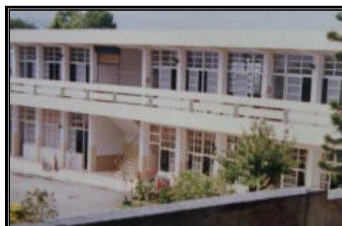
相片 2-18 南投縣埔里鎮育英國小 說明 北棟校舍 921 地震前原貌 - 正立面
