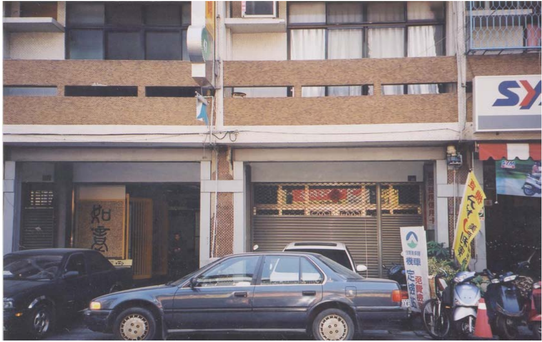
照片 6-3 騎樓增設門型鋼構架
