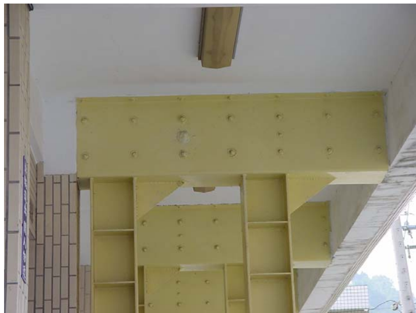
照片 6-2 頂端束制較佳的 H 型鋼骨柱（由鍾立來博士等提供）
