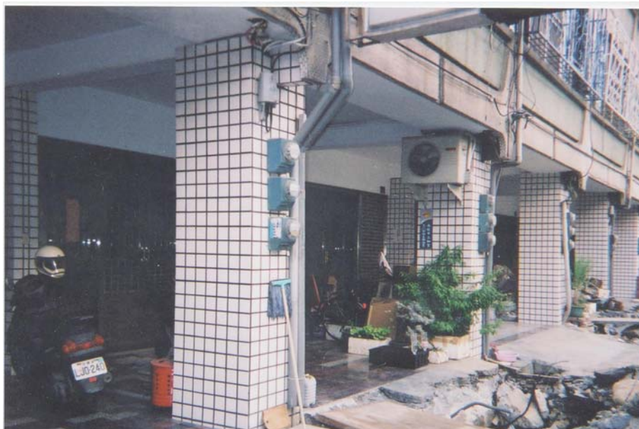
照片 6-6 以 RC 擴大柱斷面
