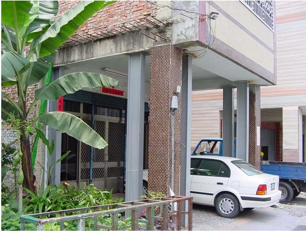
照片 6-1 騎樓增設 H 型鋼骨柱（由鍾立來博士等提供）
