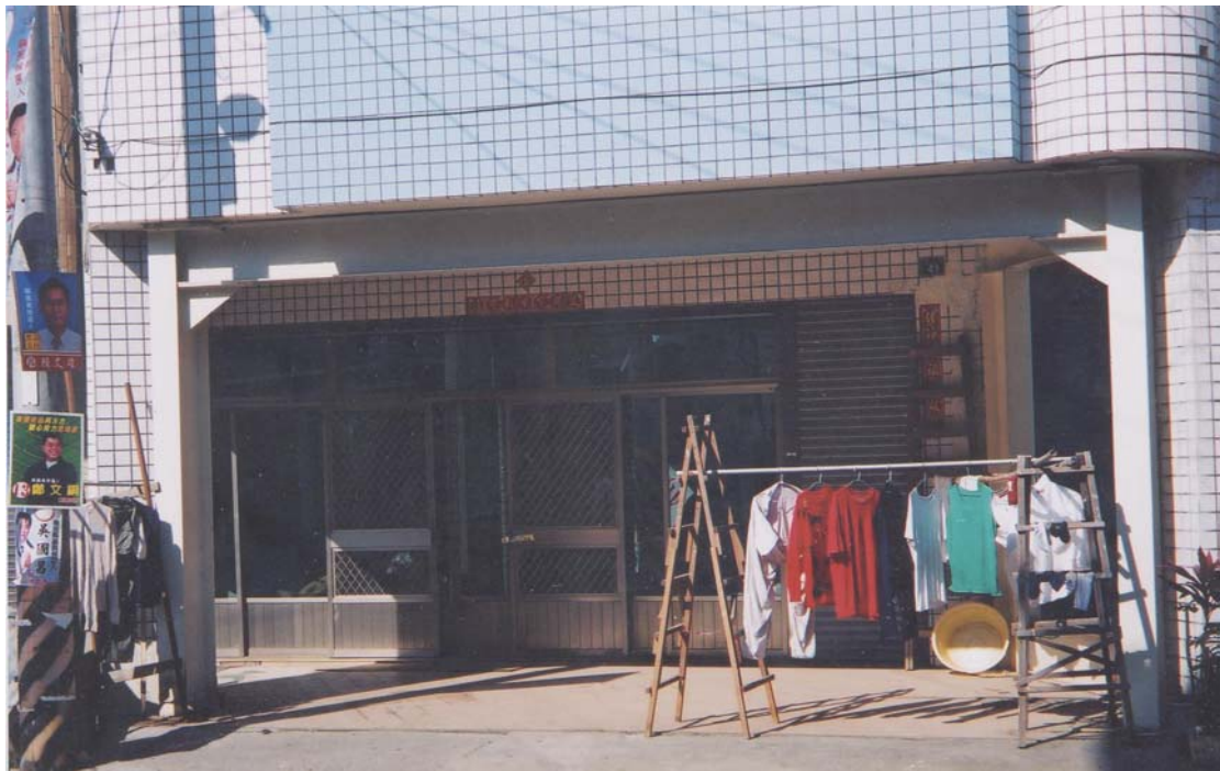
照片 6-4 門型鋼構架加牛腿
