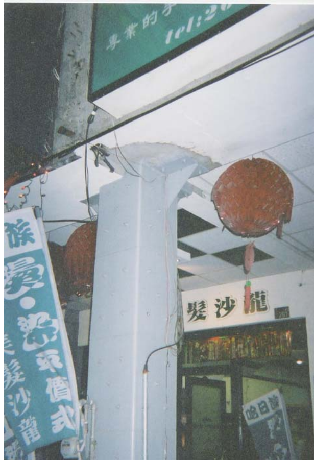
照片 6-5 以鋼板包覆騎樓柱
