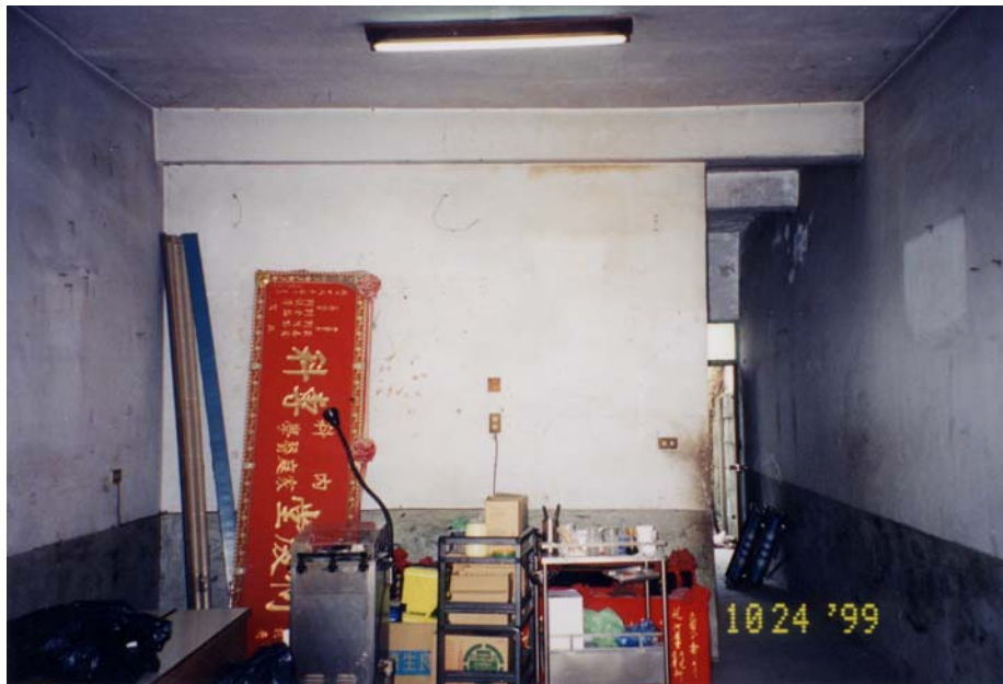
照片 2-7 具有平行騎樓方向牆壁之沿街店鋪住宅，受害輕微（一）
