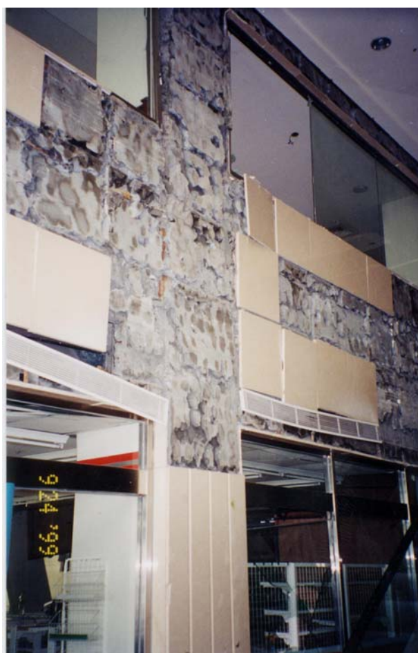
照片 2-12 磁磚掉落情形
