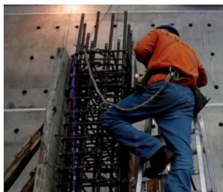
圖 11 柱鐵件塞鉚作業
