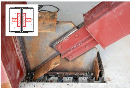
圖 7 搭接銲接接合
