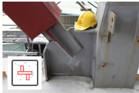
圖 8 槽接銲接接合
