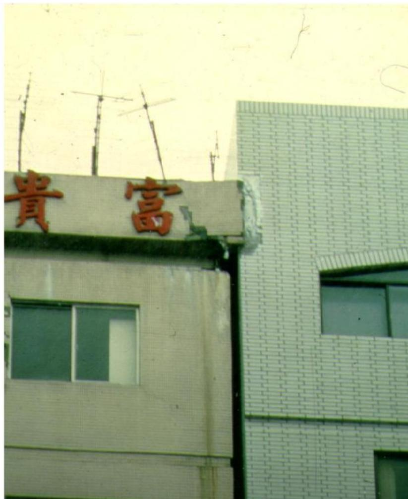
台北市二棟大廈因棟距過近且振動頻率不相同，造成頂樓碰撞受損，5月20日花蓮地震受損後修補的位置再次損壞。
