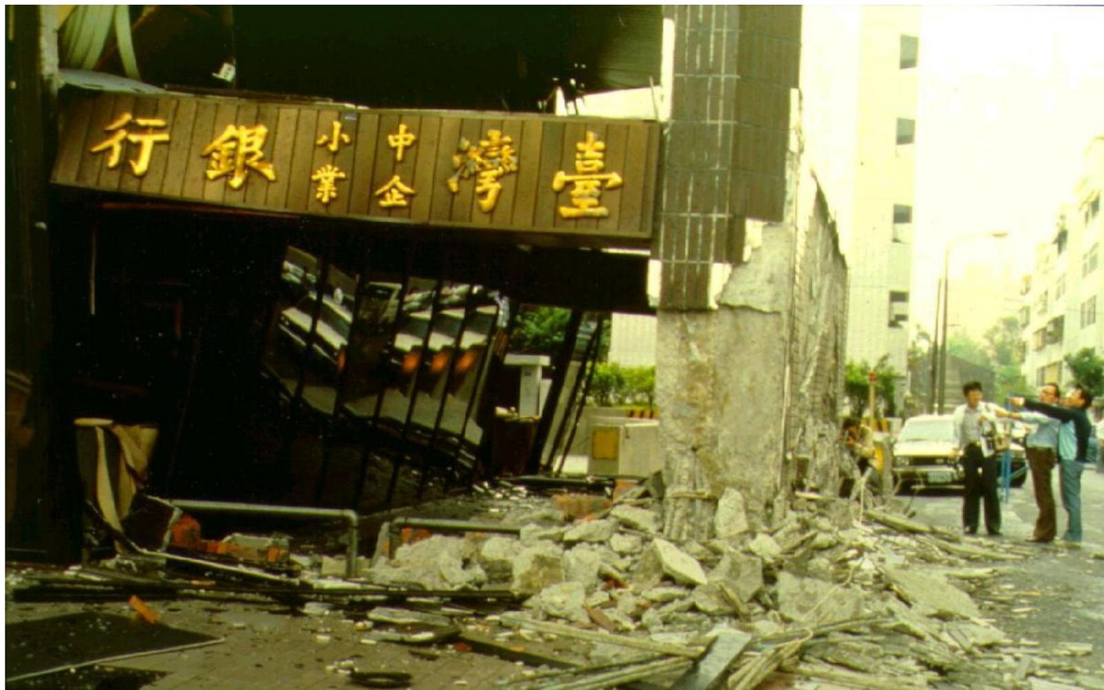
台北市復興南路一段某大廈，一樓剪力牆腳及牆邊構材部份被壓碎，鋼筋暴露且扭曲變形，牆面呈斜向之剪力龜裂，一、二樓間之混凝土樓板破裂並下陷。
