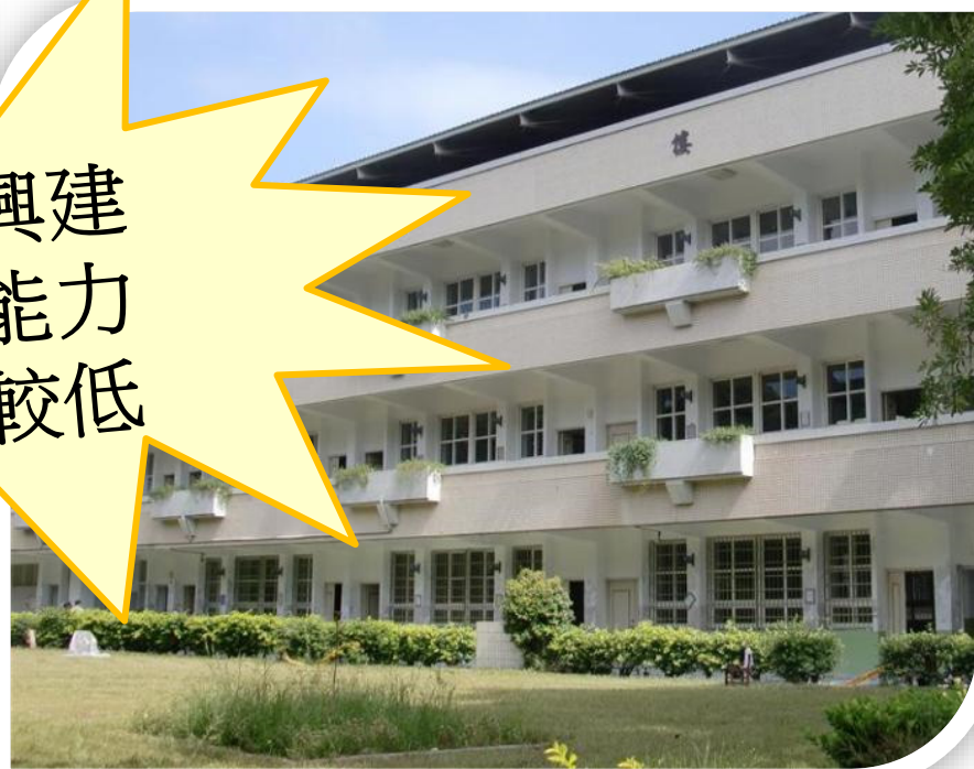
懸臂式走廊教室 (走廊無柱) 開窗率太大，易生短柱效應
