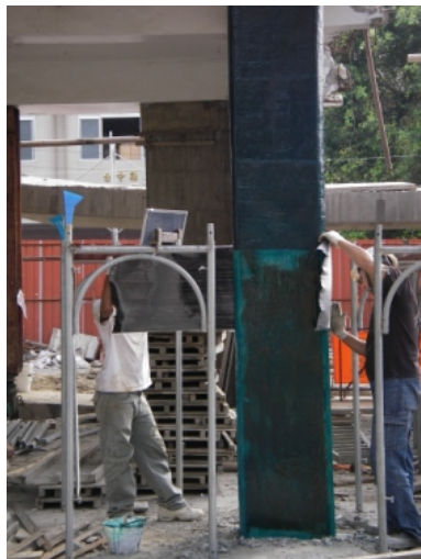
4.柱體表面黏貼纏繞碳纖維布，最後灑上硅砂以提升耐磨度
