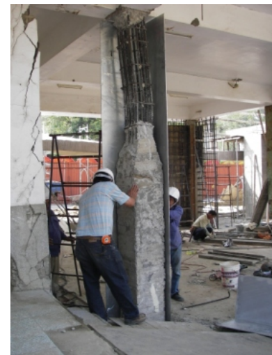
2.去除裸露鋼筋的鐵鏽後，以兩片L形鋼板包覆柱體
