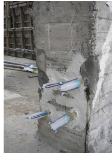
1. 打除混凝土碎塊及粉刷層後，柱體裂縫注入膠結劑填滿
