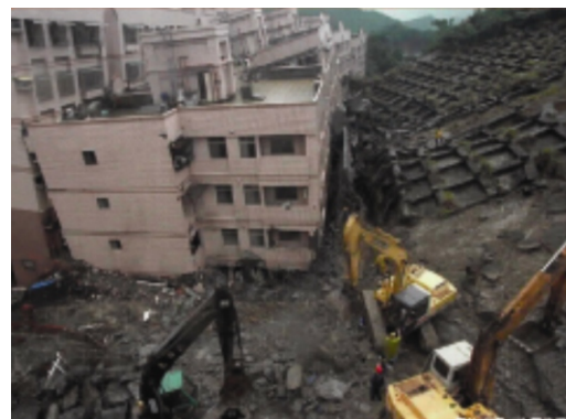
1997年發生於臺北縣汐止市的林肯大郡災變，肇因於挖除順向坡坡腳興建大樓，加上擋土牆施工不良，以致於溫妮颱風來襲時，夾帶的大雨造成地層滑移，土石衝毀大樓，釀成28人不幸死亡的事故／照片來源：財團法人地工技術研究發展基金會
