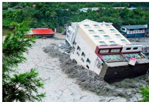
2008年辛樂克颱風夾帶的豪雨，在南投縣廬山溫泉風景區引發嚴重的土石流災情，造成二棟飯店倒塌、多家飯店地基海空／楊士德攝
