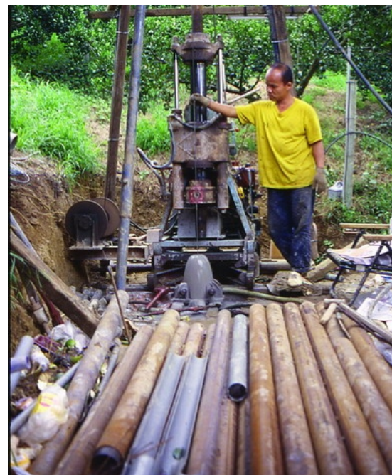
地質鑽探調查是利用機具將套管鑽入地底，以取得岩石或土壤樣本，送至實驗室分析其地質結構、組成、土壤含水量、土壤孔隙比率等／照片來源：國家型數位典藏計畫
