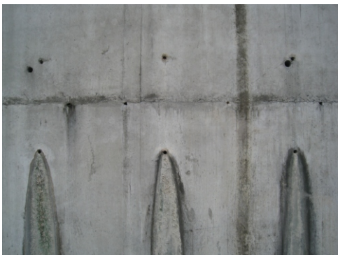
擋土牆上要有排水孔與排水設施
