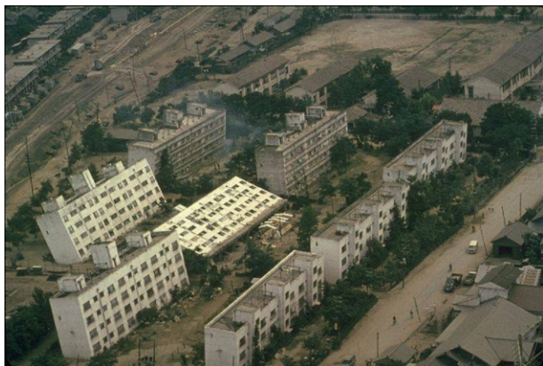
1964年日本新潟地震，土壤液化造成整排樓房傾斜或倒塌。 圖照片來源：USGS
