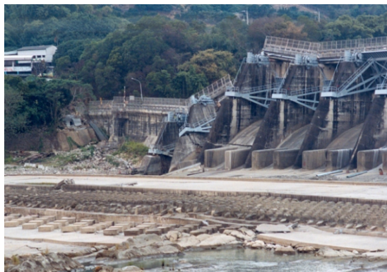
車籠埔斷層穿切石岡水壩
