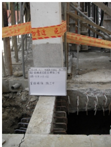
1. 挖開柱旁的地基，在地梁中植入鋼筋後，灌漿回填
