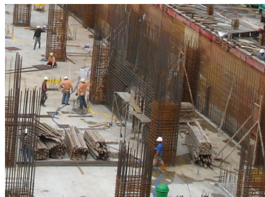
完成基礎後，組立柱子的鋼筋
