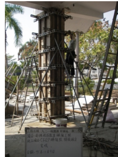
2. 將柱體裸露的鋼筋除鏽後，柱體外組立模板並以混凝土灌漿
