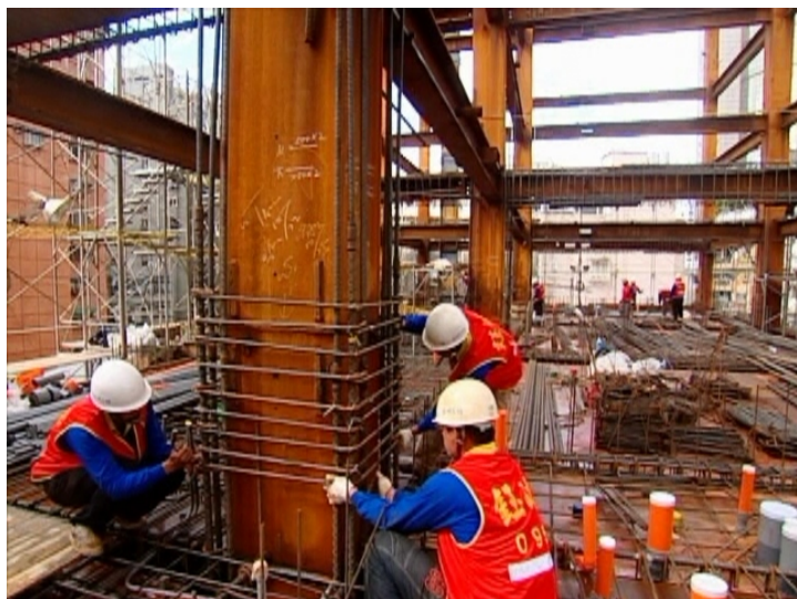
在鋼骨結構外圍組立鋼筋
