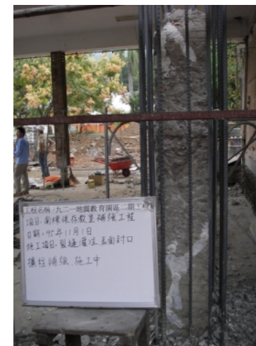
2. 打除混凝土碎塊及粉刷層，在柱體的裂縫注入膠結劑填滿
