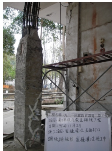
1.打除混凝土碎塊及粉刷層後，在柱體裂縫注入膠結劑填滿
