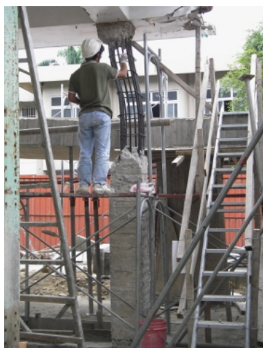
2. 打除混凝土碎塊及粉刷層，去除鋼筋裸露處的鐵銹
