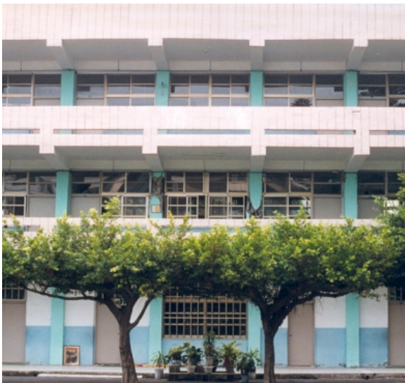
臺中縣大里市塗城國小在集集地震的震損情形。照片中，一樓柱子兩側有窄牆，一樓結構仍然完整；但柱旁沒有窄牆的二樓則震損。
