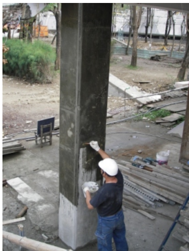
3.取下模板後，在柱體塗上底漆打底，並進行表面批平
