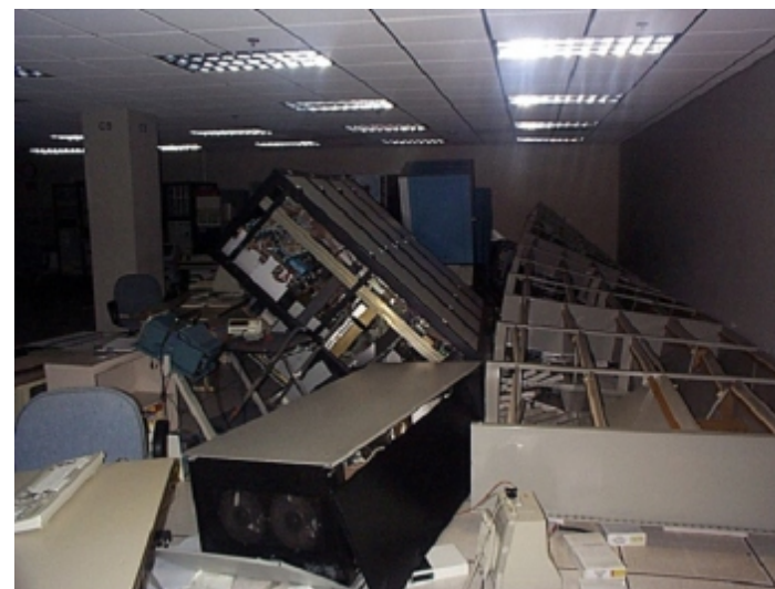
未固定好的櫥櫃在地震中倒塌，相當危險
