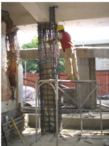
3. 去除裸露鋼筋的鐵銹後，綁紮箍筋和繫筋
