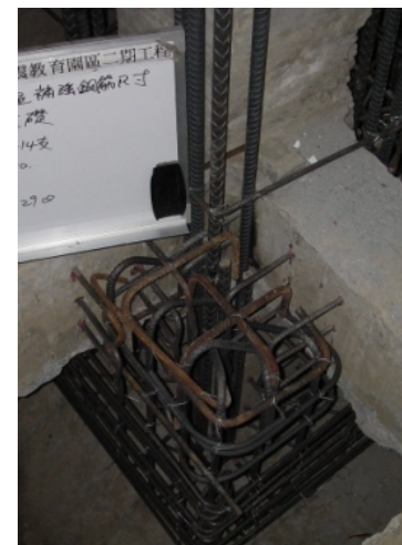
1. 挖開柱旁的地基，在地梁中植入鋼筋和主筋後，灌漿回填
