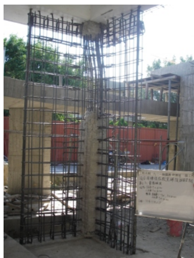
3. 補強柱體裂縫後，鑽孔植入鋼筋並綁紮成牆的形狀
