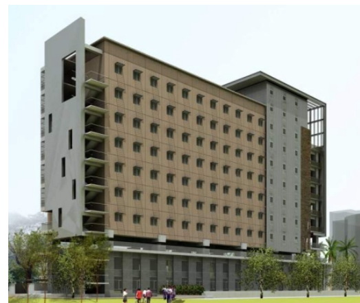
臺大土木系研究大樓 (二樓隔震)
