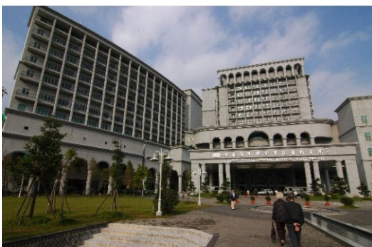
臺北縣新店市慈濟醫院 (基礎隔震)
