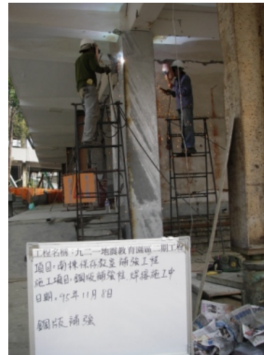
3.將兩片鋼板焊接封口後，於柱頭處灌注混凝土
