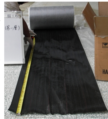
補強工程用的碳纖維布
