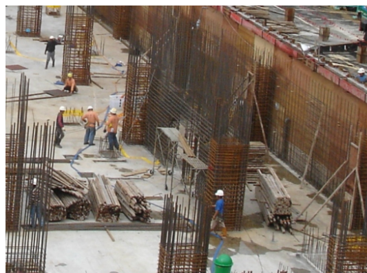
完成基礎後，組立柱子的鋼筋
