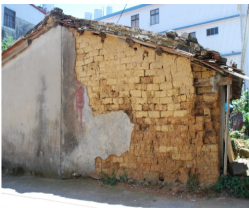
土角厝，部分石灰牆面裝飾已經剝落
