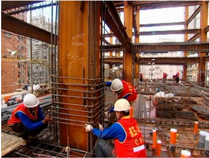
在鋼骨結構外圍組立鋼筋
