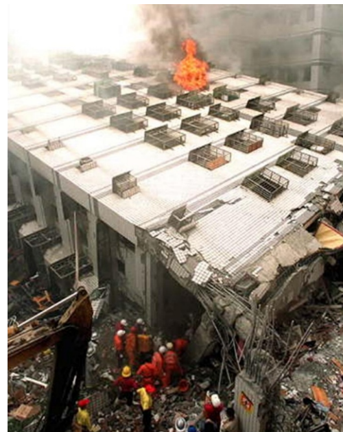
臺北縣新莊市「博士的家」在集集地震中倒塌，造成43人死亡、2人失蹤。照片中的殘柱可看出主筋同位搭，而且不見箍筋。
