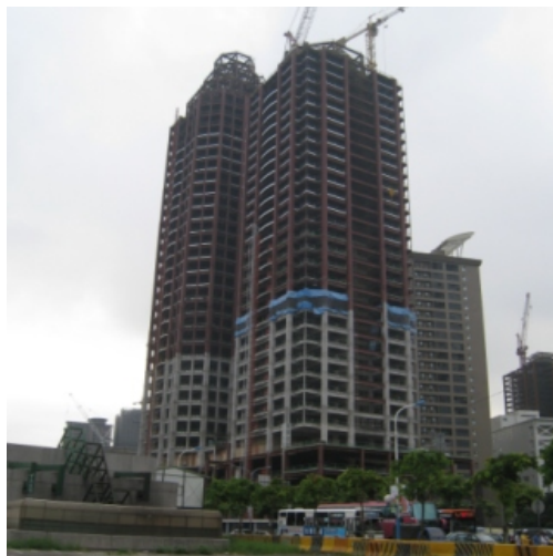
正施作防火披覆工程的鋼骨建築
