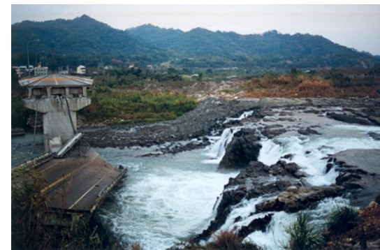
倒塌的埤豐橋及斷層錯動形成的小瀑布
