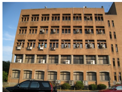
臺北市大安區一棟公共建築，二樓壁量少且柱子細長，形成軟弱層現象，柱子多震損
