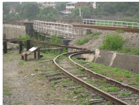
彎曲的舊鐵軌與一旁新建的鐵道
