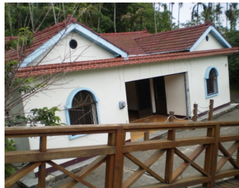
受地表滑動影響傾斜的民宅
