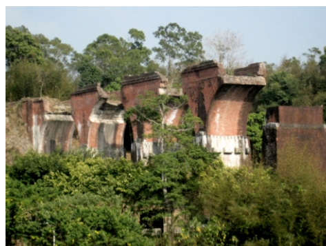
龍騰斷橋，拍攝於1999年集集地震後。橋梁結構的優雅造型，加上地震遺跡保存良好，斷橋成為人潮熱絡的觀光景點
