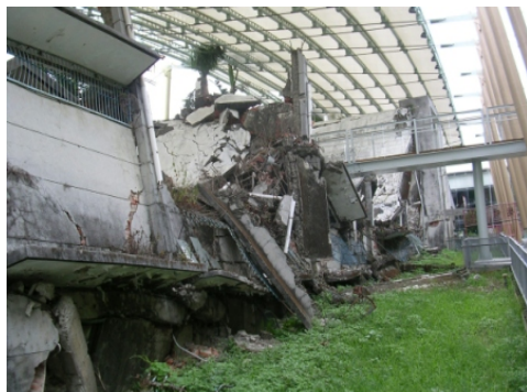
光復國中倒塌的北棟教室，現以鋼構薄膜棚架遮蓋保存
