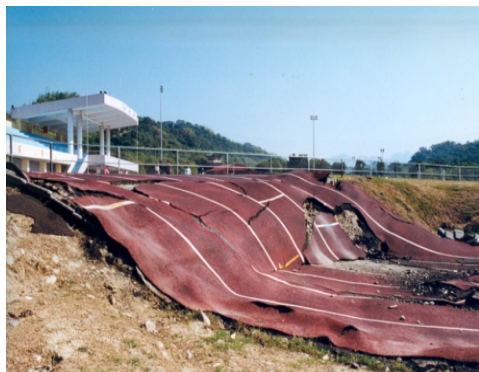
車籠埔斷層錯動，光復國中操場垂直抬升2.4公尺，水平錯動3.4公尺
