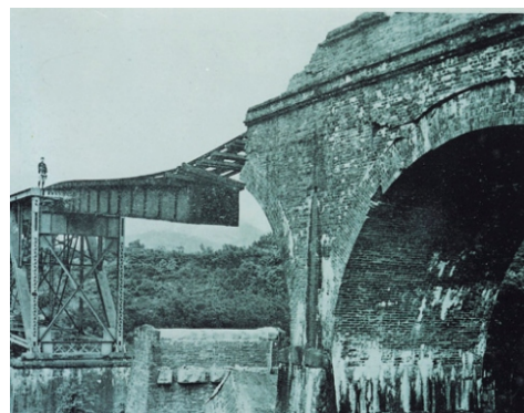
龍騰斷橋，拍攝於1935年關刀山地震後，連結桁架的磚拱已經塌落／拍攝者不詳
