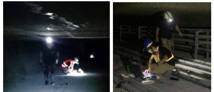
圖二 於箱梁內量測振動訊號及檢測外置預力鋼腱
