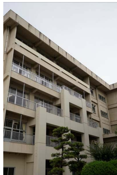
圖二 DUF 工法於現地之施工案例
