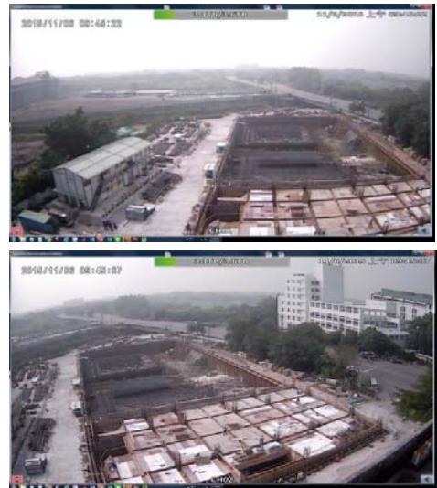
第二實驗設施建築物興建施工現況
