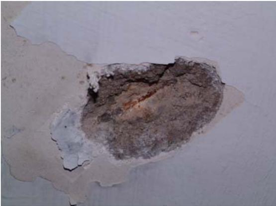
圖三 馬祖高中教學大樓一樓樓板，樓板鋼筋鏽蝕。
