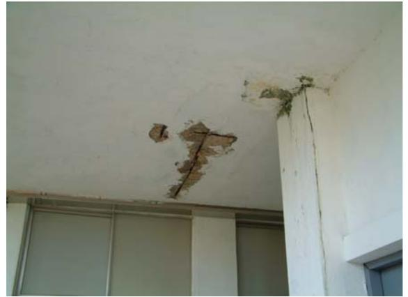
圖四 照片中可發現已修補過的痕跡，但混凝土剝落情形依舊
