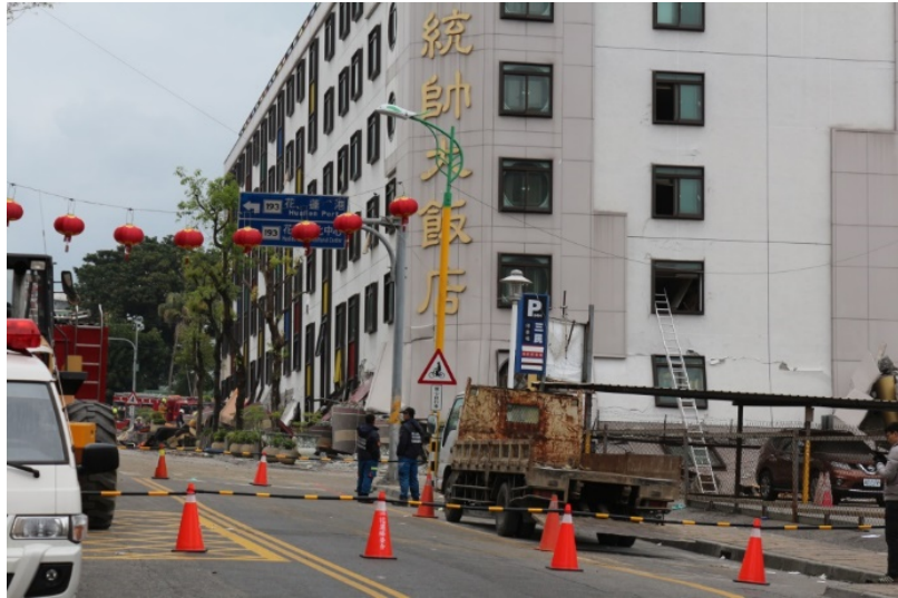
(A) 統帥飯店倒塌
