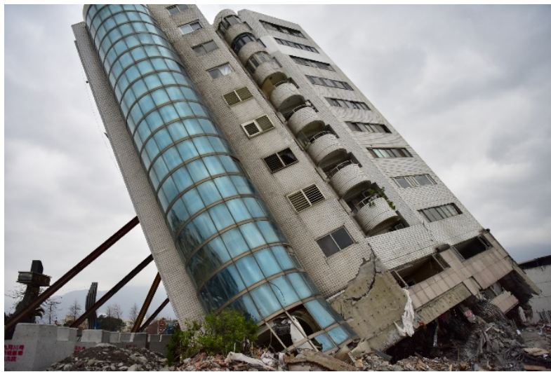
(B) 雲門翠堤大樓倒塌
