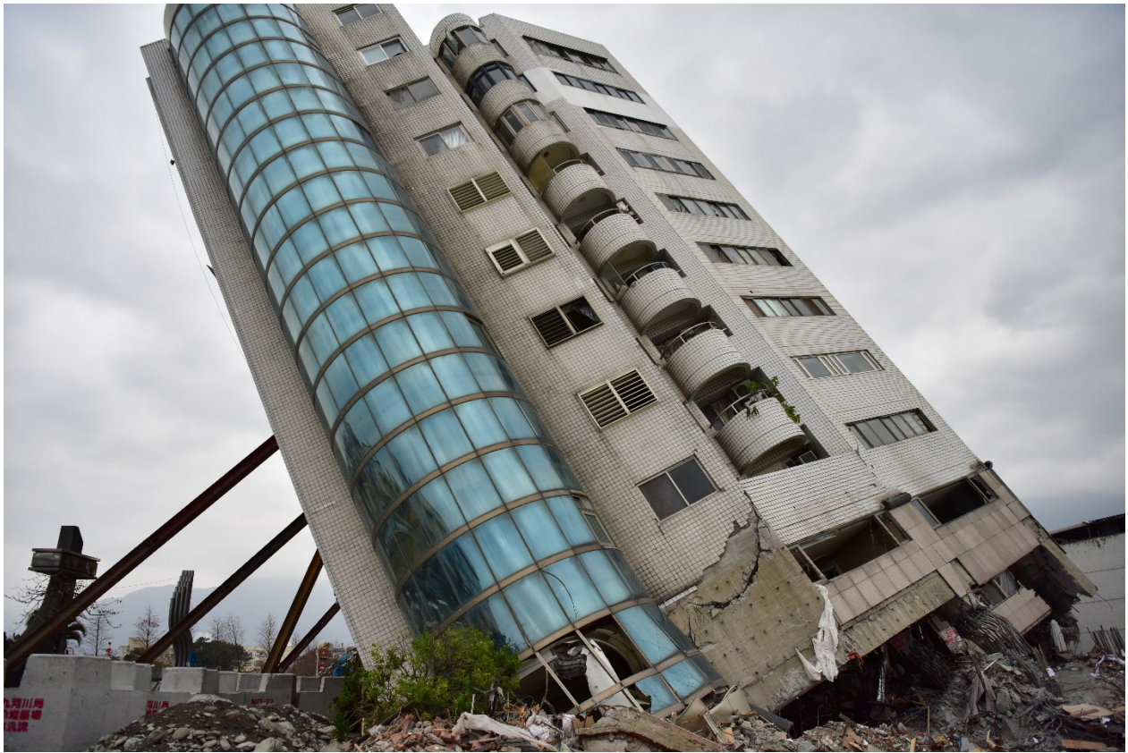
圖 3：2018 年花蓮地震之樓房崩塌
