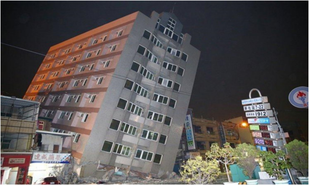
圖 2：2016 年美濃地震之樓房崩塌
