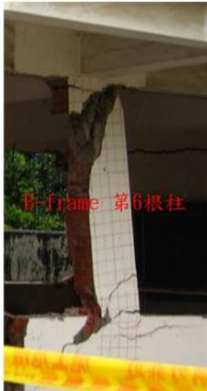
圖 60 口湖國小局部柱體破壞照片
