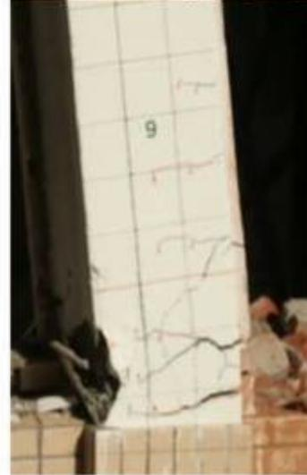
圖 66 新城國中局部柱體破壞照片
