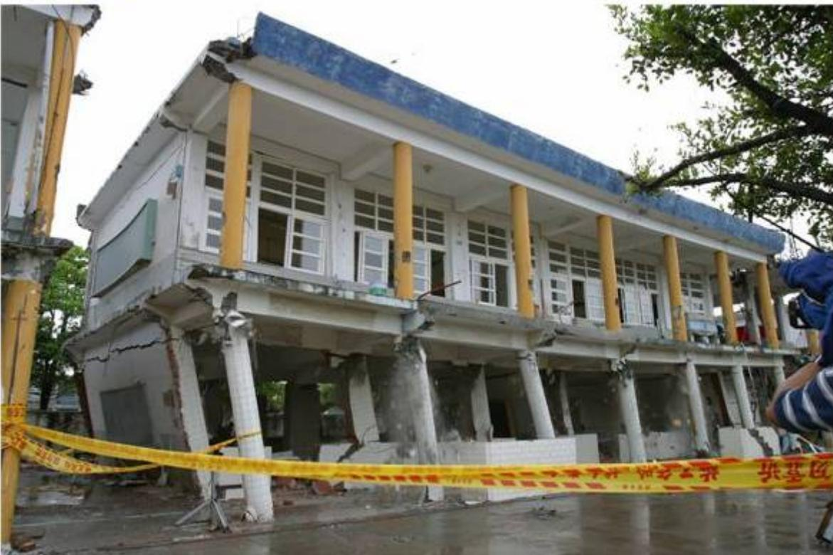
圖 59 口湖國小空構架試體試驗照片
