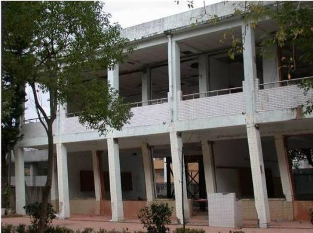
圖 64 新城國中空構架試體試驗照片(正面)
