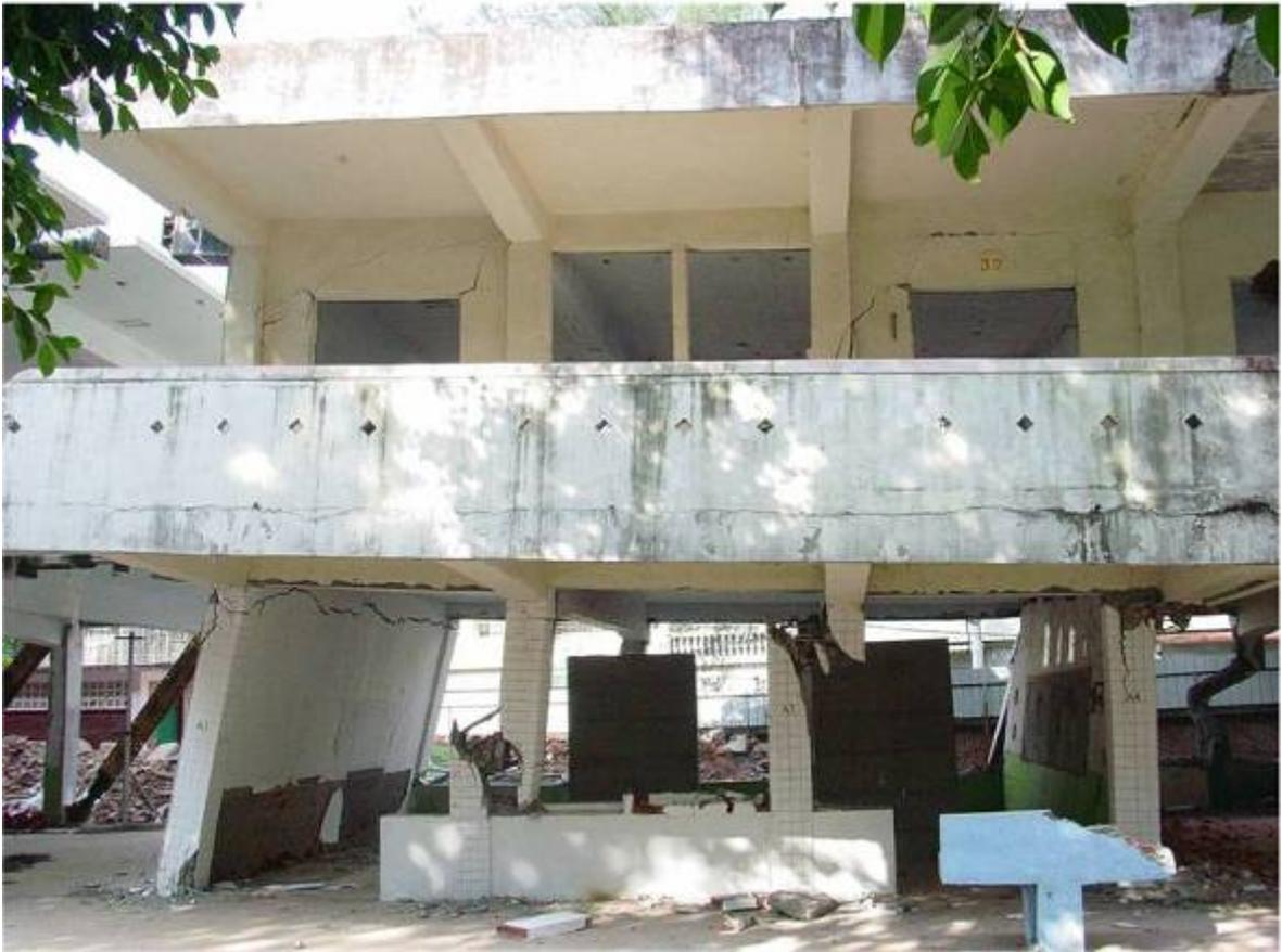
圖 71 瑞埔國小試體二試驗照片(破壞後)
