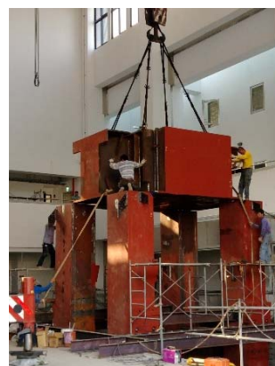
(a) 鋼構架現場安裝
