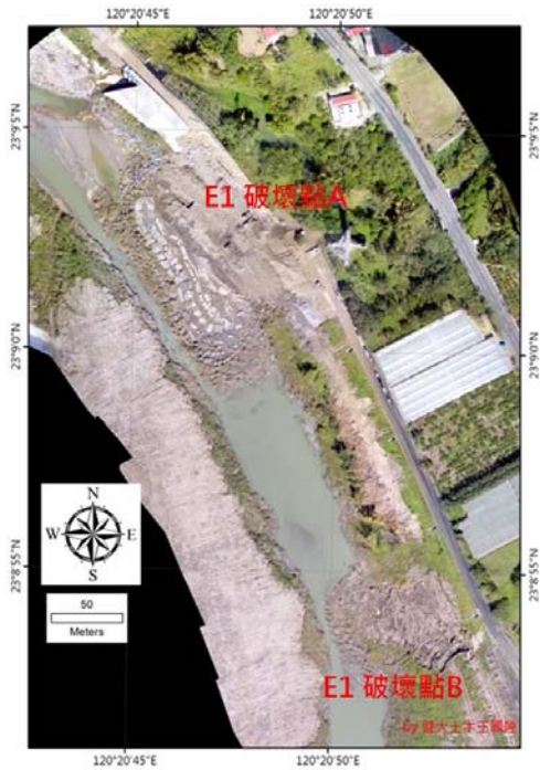
(A) 日新護岸 E1 兩處破壞點 A、B
