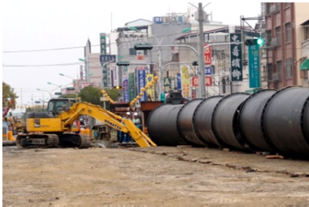
圖五 永康區永大路二段送水管置換情形
