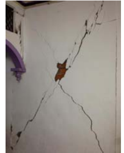
(b) 磚牆 X 型剪力裂縫
