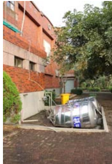
圖六 玉井國中多處水塔受損
