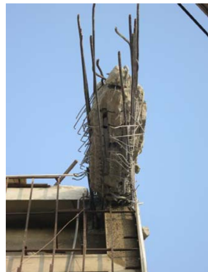
(b) 柱箍筋 90° 彎鉤
