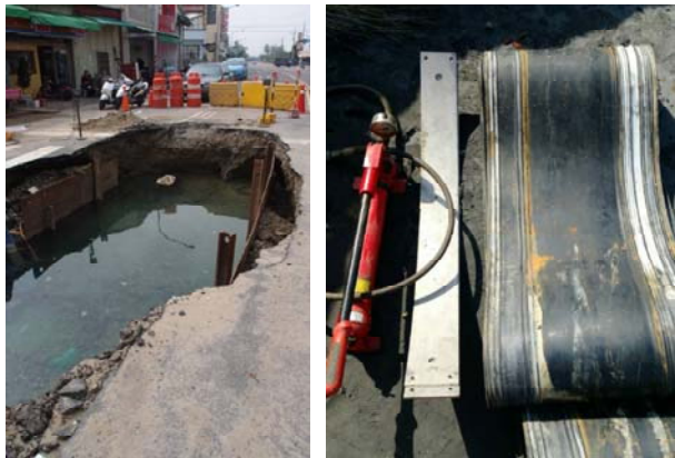
圖六 安南區長和路三段送水管開挖與內套環修漏情形
