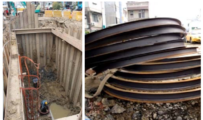
圖三 新化區忠孝路送水管深開挖修漏與 C 形鋼環備料情形
