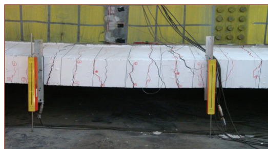
圖三 下翼板混凝土開裂
