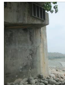
圖九 高美大橋引道輕微下陷、伸縮縫距離增大、橋台翼牆護欄開裂、欄杆毀損、橋墩產生撓曲裂縫等震災
