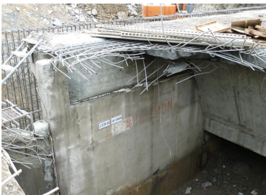
圖六 箱梁外側懸臂板修復作業中
