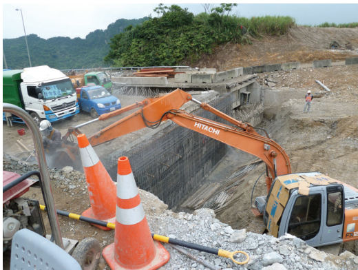
圖五 橋台背牆修復作業中
