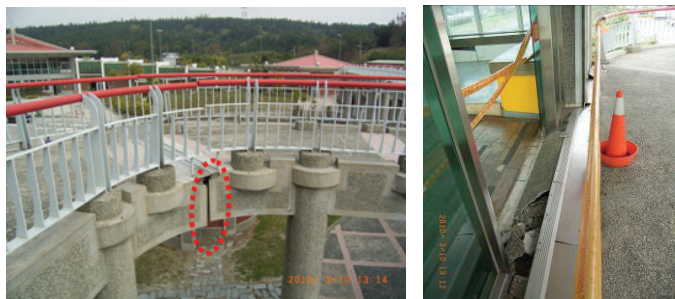
圖十一 關廟休息站人行跨越鋼橋引橋伸縮縫處出現損傷，固定端伸縮縫擠壓變形
