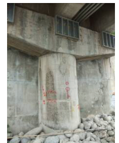
圖九 高美大橋引道輕微下陷、伸縮縫距離增大、橋台翼牆護欄開裂、欄杆毀損、橋墩產生撓曲裂縫等震災
