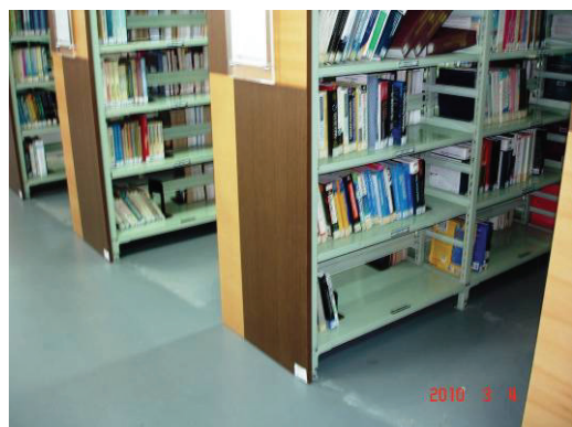
圖十四 書架未傾倒但於地面留有明顯滑移痕跡(館方提供)
