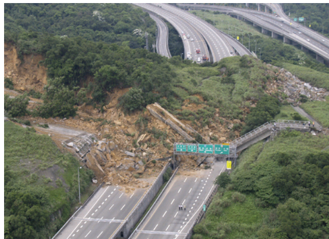
圖一 靠近瑪陵坑七堵路段，山崩空照圖(照片來源：空警隊)
