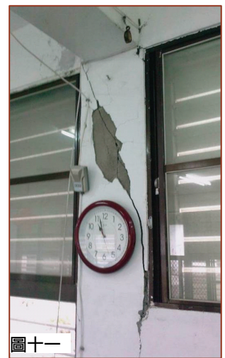
圖十 月眉國小專科教室西南側氣窗短柱剪力破壞照片，裂縫寬度達 5mm。圖十一 月眉國小專科教室東北側氣窗短柱剪力破壞照片，裂縫寬度達 10mm。
