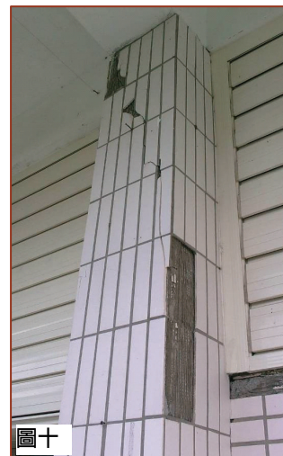
圖十 月眉國小專科教室西南側氣窗短柱剪力破壞照片，裂縫寬度達 5mm。圖十一 月眉國小專科教室東北側氣窗短柱剪力破壞照片，裂縫寬度達 10mm。
