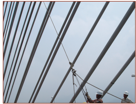
圖三 施加拉力，釋放扣環，造成鋼纜振動
