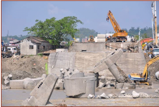
圖三 旗尾橋損壞情形(劉光晏拍)
