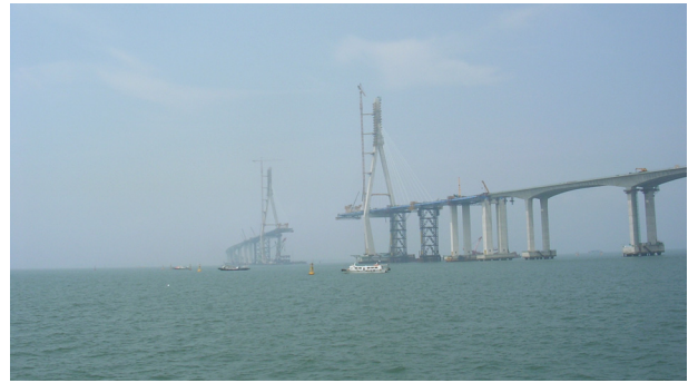
照片二 船舶駛入海洋中參觀興建中的仁川斜張橋
