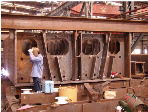
照片二 反力梁上部於工廠加工狀況
