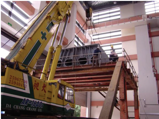
照片三 反力梁吊裝於臨時重型支撐架情形
