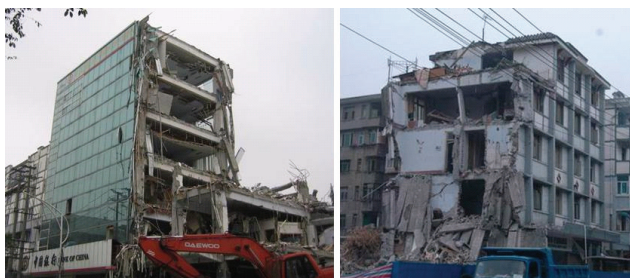
圖三 都江堰市正在拆除的中國銀行及鄰近震毀之民宅
