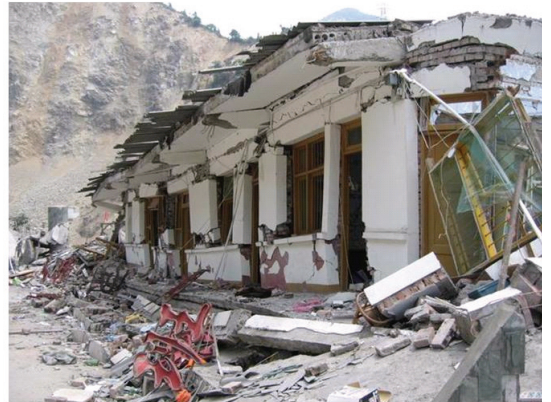
圖二十三 通往映秀鎮內之臨時搭建倍力橋(上)，以及橋頭旁損毀之道路班廳舍
