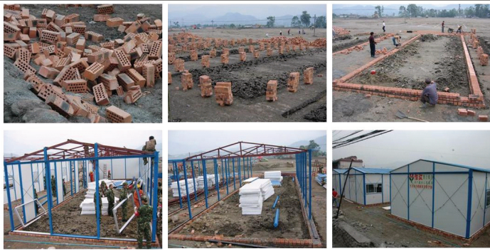
圖十一 過渡安置用活動板屋之組合過程
