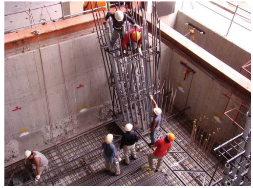
照片四 預力鋼棒基座
