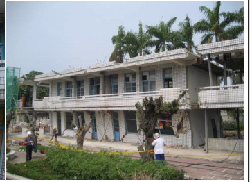
圖六 預力鋼棒補強構架試體
