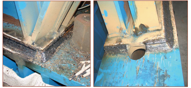
圖五 焊道修復完成
