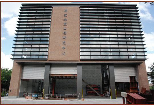
圖二 實驗室擴建外觀實際情形
