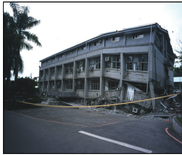
圖七 底層挑高、隔間牆壁打通、頂樓加蓋
