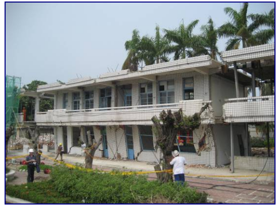
圖五 後拉式預力鋼棒補強試體試驗前後照片
