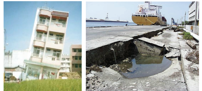
圖五 921 地震時土壤液化造成霧峰民房傾斜 (左圖) 及臺中港碼頭下陷 (右圖)
