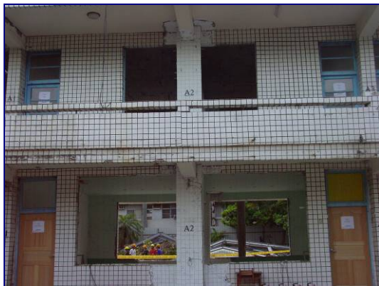
圖四 擴柱補強試體試驗前後照片
