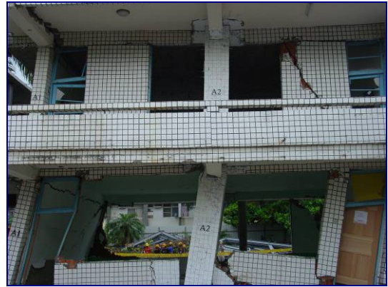
圖四 擴柱補強試體試驗前後照片
