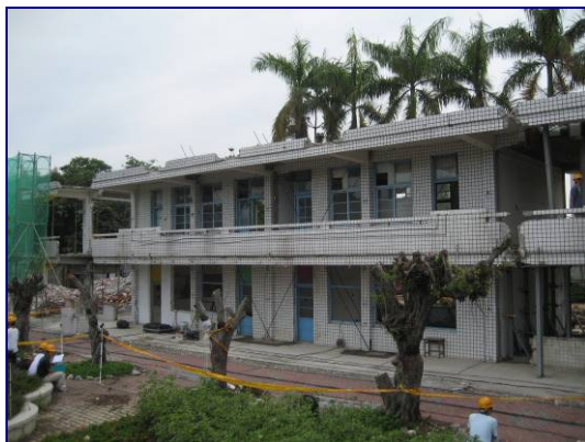
圖五 後拉式預力鋼棒補強試體試驗前後照片
