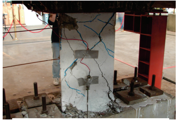
圖四 柱試體 SH5 於 PGA=1600 gal 下之破壞圖
