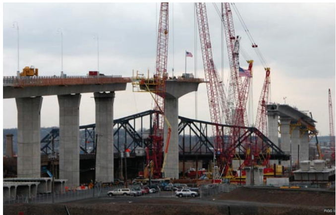
(a) 橋樑主跨施工
