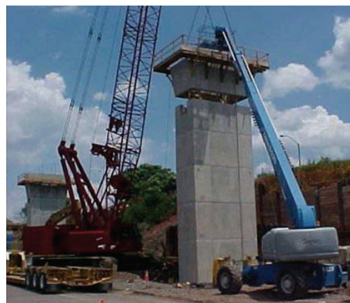
(b) 橋墩節塊安裝
