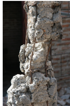
圖十九 加強磚造的 RC 桿件 圖二十 地震中存活的加強磚造民宅
