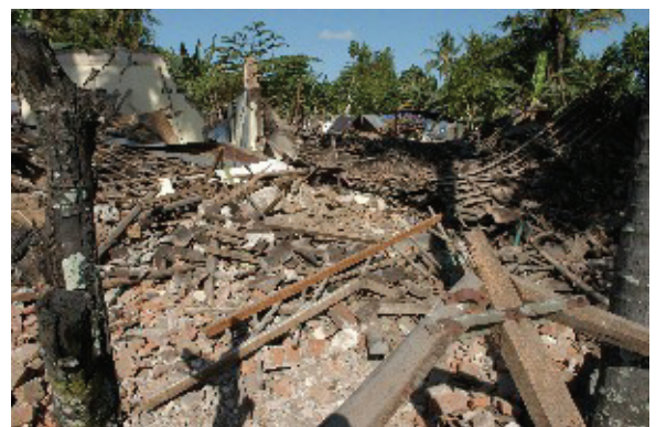
圖十六整區民宅倒塌的情況
