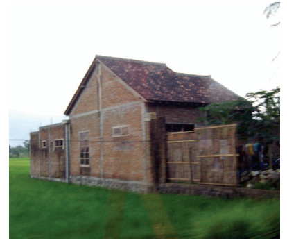
圖十九 加強磚造的 RC 桿件 圖二十 地震中存活的加強磚造民宅
