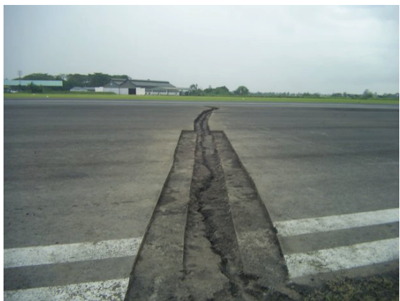
圖三十 日惹機場跑道受損情況
