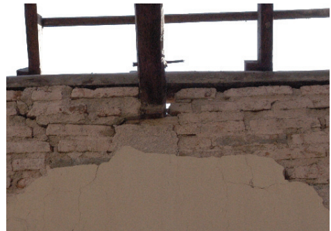
圖十五 SMK 建築屋架之支承情況
