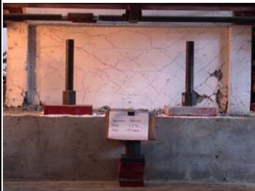
圖四 試體 SMAC 之破壞照片
