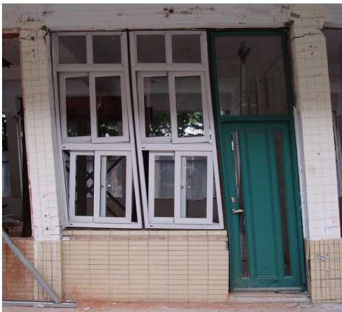
圖四 頂層位移比達 3.0% 時門窗變形情況 (玻璃仍保持完好)
