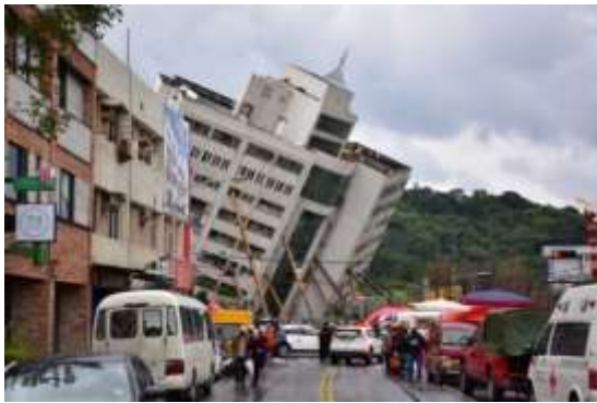
(a)倒塌正面
