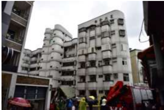
(a)倒塌正面
