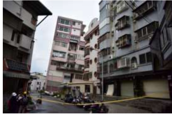
(b)倒塌背面
