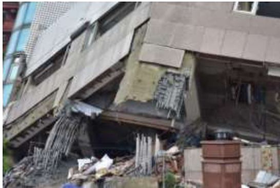
(g)柱主筋同位搭接
