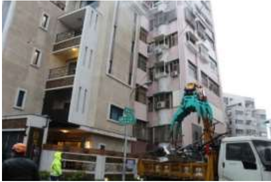
(a)倒塌正面
