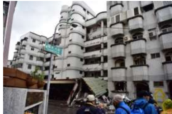
(b)倒塌正面
