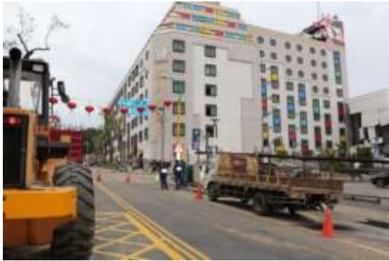
(a)倒塌正面
