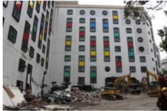
(b)倒塌背面
